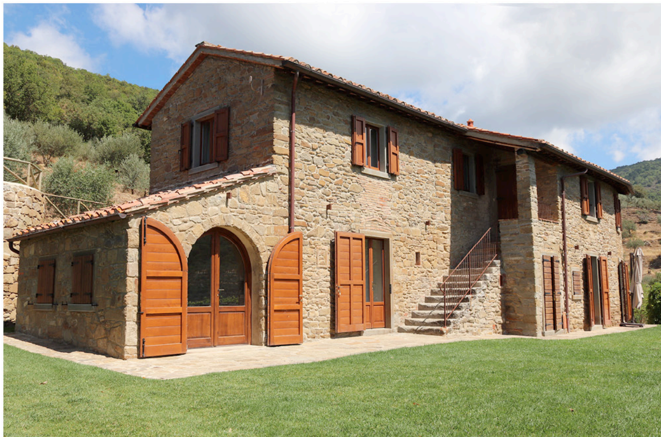
Le ristrutturazioni firmate Cosci.
