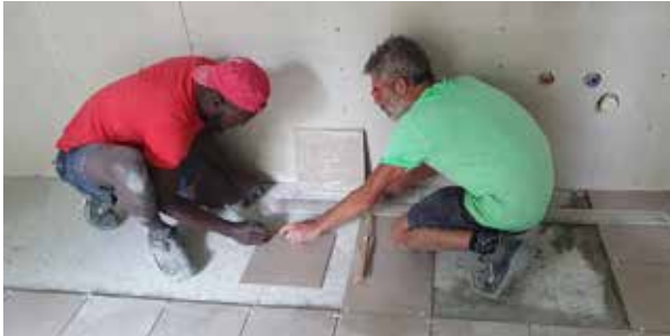
17 - Posa pavimenti e rivestimenti, Agosto 2021 (EDILPIU')
