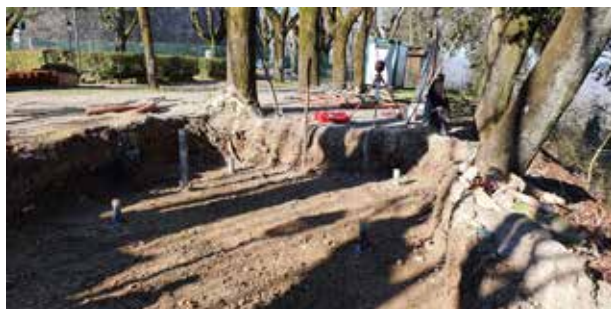
3 - Scavo Fondazione, Marzo 2021
