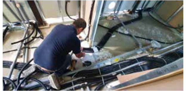
16 - Posa impianto elettrico (ELETTRICA LANDI)
