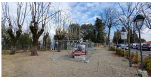
1- Inizio allestimento cantiere, Gennaio 2021
