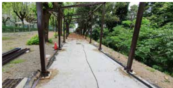
8 - Montaggio struttura e guide pannelli, (VAGNOLI ANDREA)
