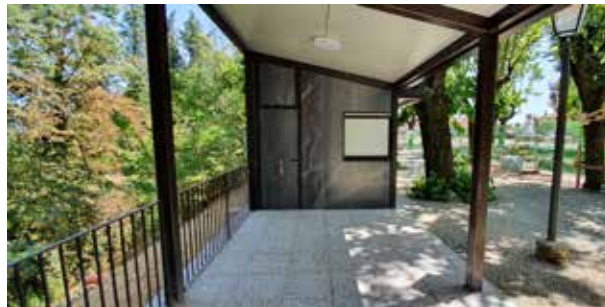
19 - Posa Pavimento portico (EDILPIU')
