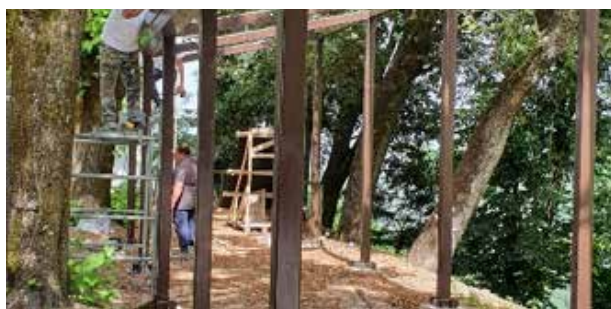
9 - Predisposizione per il montaggio del tetto (VAGNOLI ANDREA)
