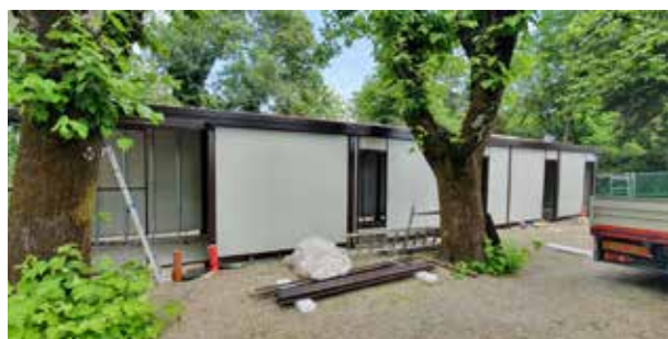
10 - Montaggio tetto e pareti (VAGNOLI ANDREA)
