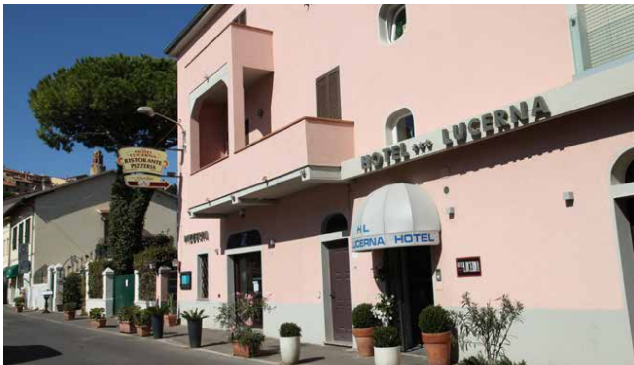
La struttura nel centro di Castiglione della Pescaia
