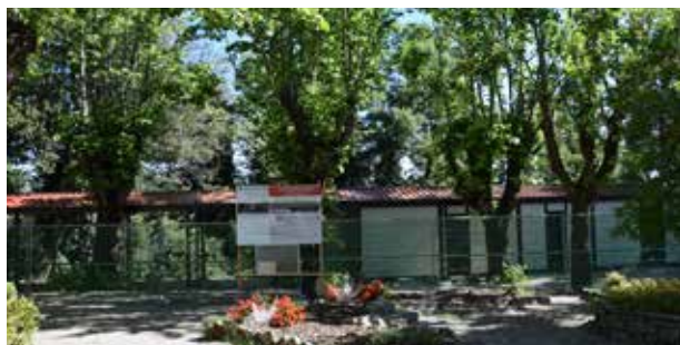
7 - Inizio Lavori Lotto 2, Aprile 2021
