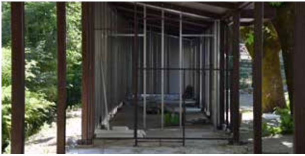
13 - Dettagli interno, montaggio pareti in cartingesso (EDILPIU')
