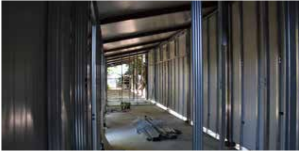
15 - Dettagli interno, montaggio pareti in cartingesso (EDILPIU')
