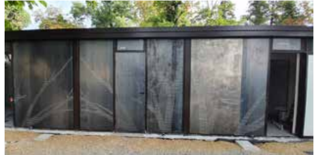
18 - Montaggio Pannelli in lamiera CORTEN® microforati (VERNIFER)
