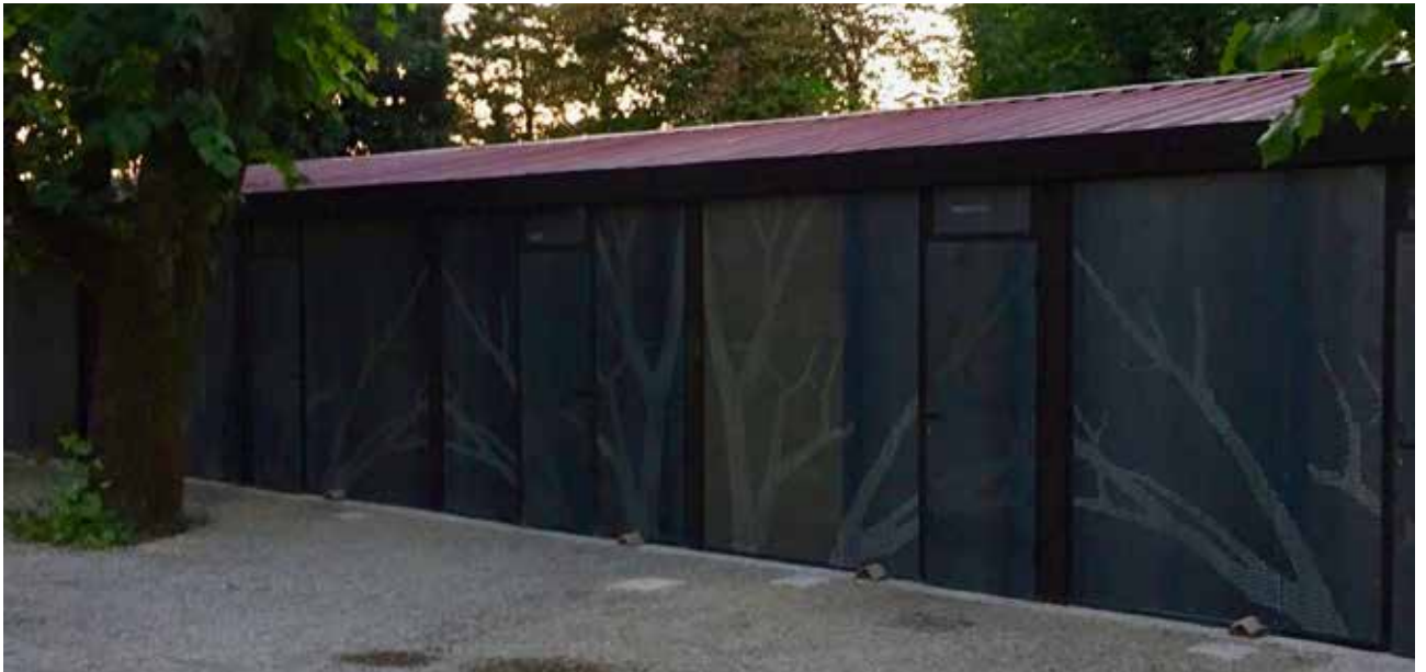
20 - Struttura ultimata, Agosto 2021
