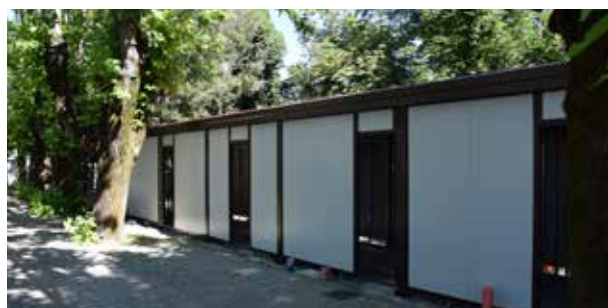
12 - Montaggio pannelli di coibentazione ISOPAN® ultimato, Giugno 2021
