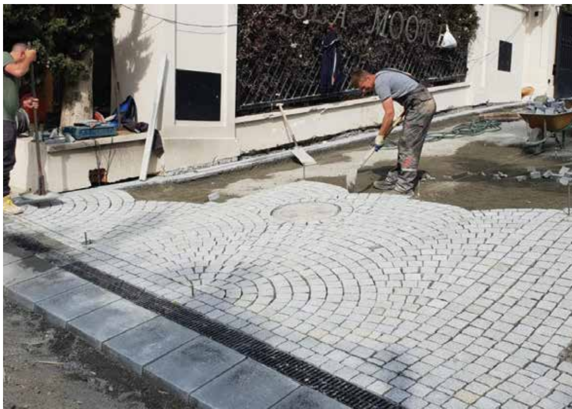
Gli uomini di Eurosteine al lavoro
