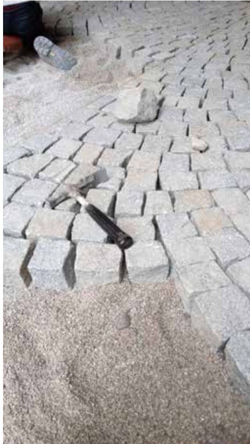
La messa in opera
