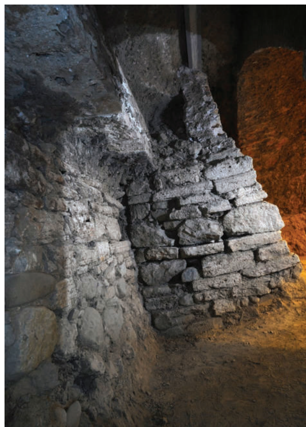
Fondazioni Tempio Etrusco
